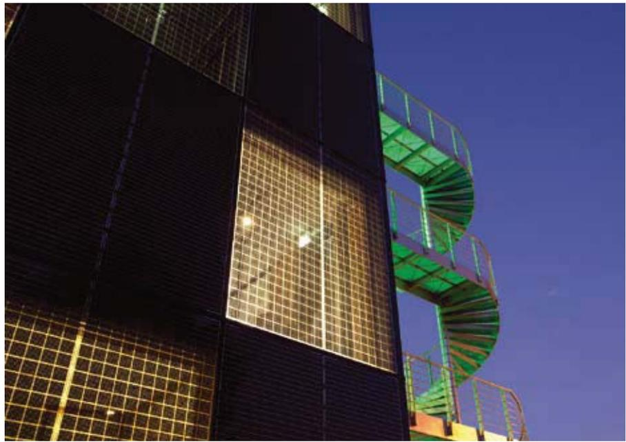
Im Energiewürfel der Stadtwerke Konstanz lässt die Fassade aus transparenten Solarzellen Licht ins Gebäude. Sie setzen auch nachts im Zusammenspiel mit farbigen LED-Leuchten optische Akzente.
