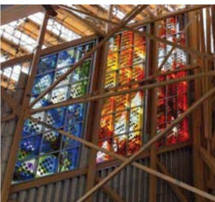
An modernen Fassaden und auch an Kirchenfenstern setzen Solarzellen gestalterische Akzente.
